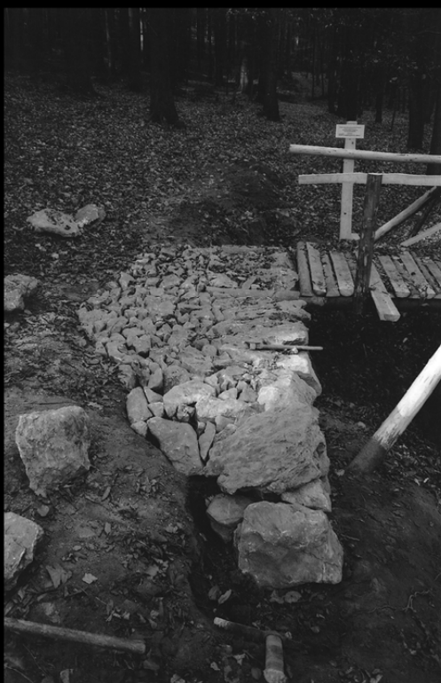
Stabilizace lesní cesty - efektivní využití těžených sedimentů
