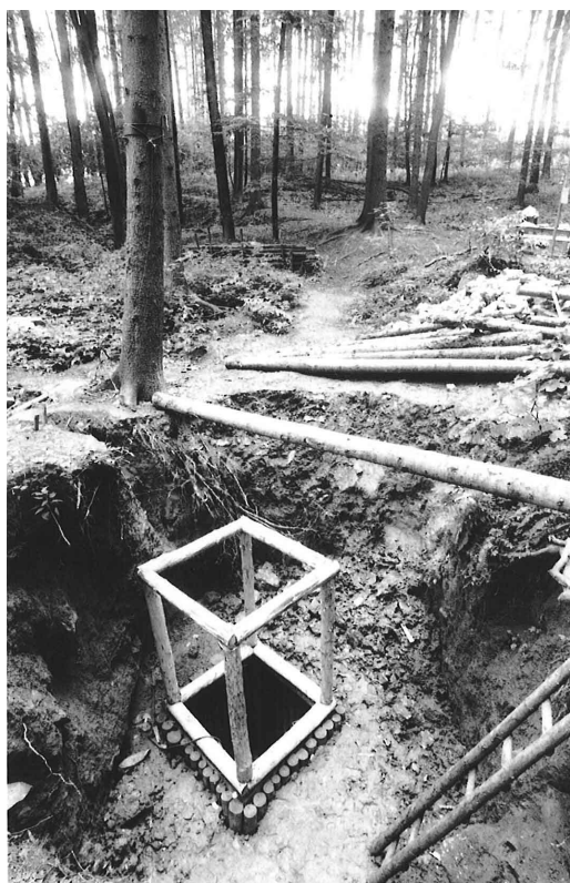
Foto: Způsob výstavby výdřevy do Ponorného hrádku za současného zasypávání průzkumné sondy v Novodvorském ponoru (1992-1993)
