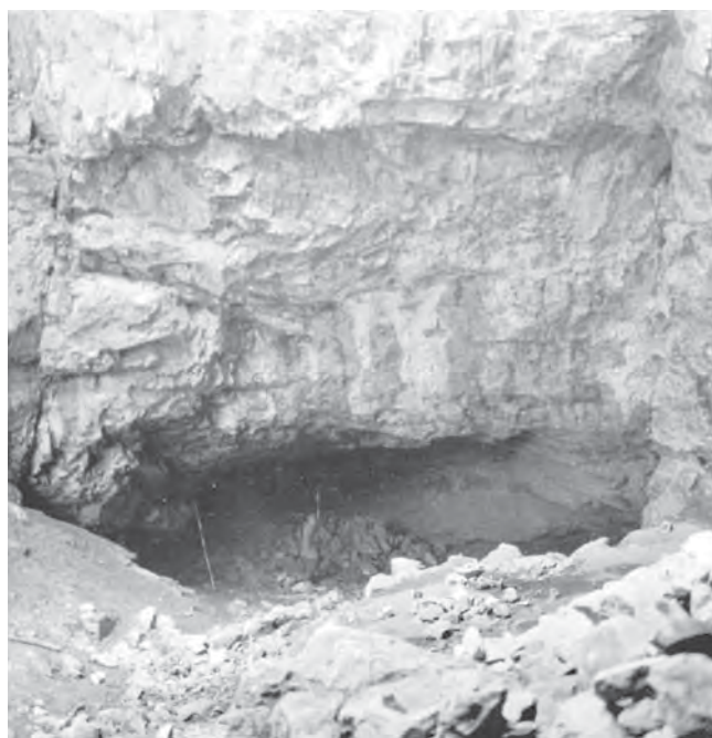
Obr. V.6. Bourání staré zazdívky Dolního vchodu v době válečných úprav dne 27. 6. 1944 (foto N. Havlíček, archiv K. Absolon, MZM Brno).
