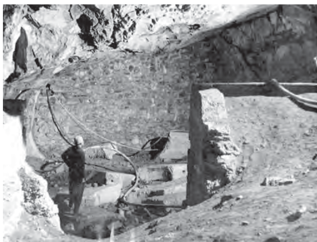
Obr. V.12. Před válečnou zazdívkou z roku 1944–1945 jsou zachyceny půlkruhové betonové podstavce pro regenerační kotle. Fotografováno v 80. letech 20. století (archiv J. Poláček).
