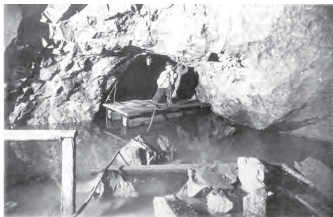
Obr. IV.17. Práce s kamenovrtnou soupravou nad hladinou Šenkova sifonu, 1912-1913 (archiv ZO ČSS 6-01 Býčí skála).
