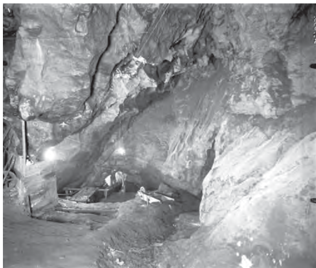
Obr. IV.18. Vedení elektrického proudu pro kamenovrtné práce nad hladinou Šenkova sifonu, 1912-1913 (archiv ZO ČSS 6-01 Býčí skála).
