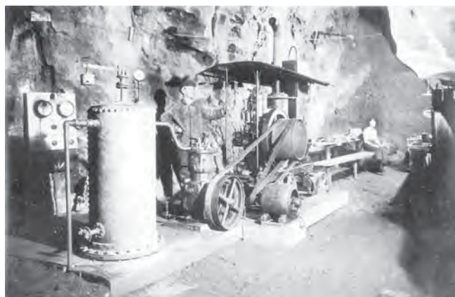
Obr. IV.16. Instalace strojovny v Prstu u Šenkova sifonu, 1912-1913 (archiv ZO ČSS 6-01 Býčí skála).
