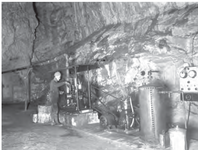
Obr. IV.23. Strojovna v Předsíni Býčí skály zajišťující chod pumpy u Šenkova sifonu, 1920–1921 (archiv K. Absolon, MZM Brno).
