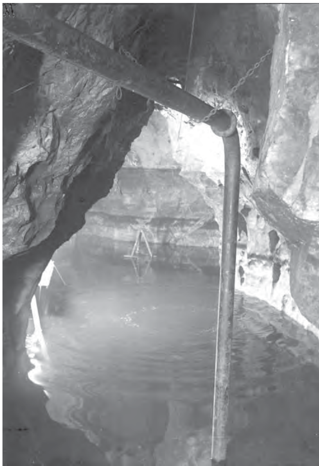
Obr. IV.26. Potrubí pro čerpání vody z Šenkova sifonu pro přístup do Nové Býčí skály, 1920–1923 (archiv K. Absolon, MZM Brno).
