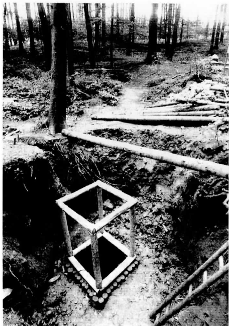
Foto 6 Způsob budování výdřevy vstupní šachty do nově objevené jeskyně č. 1410A Ponorný Hrádek, za současného zasypávání průzkumné sondy na dně závrtu Novodvorského ponoru (1992–1993) (foto M. Šenkyřík)
