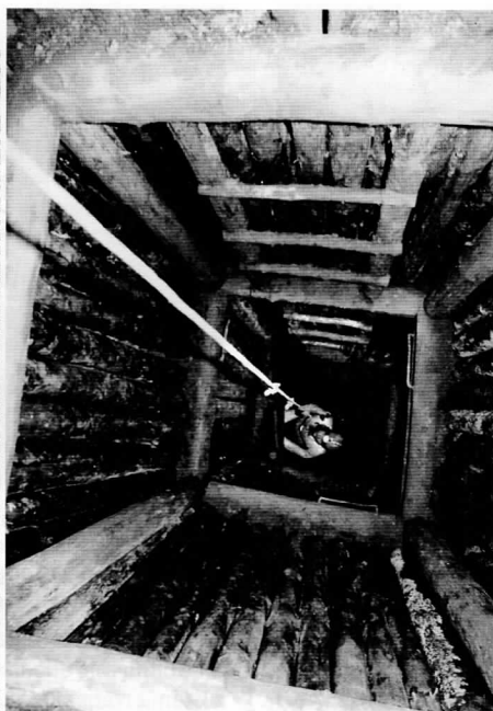
Foto 7 Výdřeva vstupní šachty do Ponorného Hrádku krátce po dokončení vr. 1993 (foto M. Šenkyřík)
